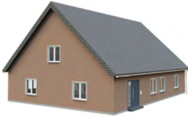
Haus ohne äußeren Blitzschutz
