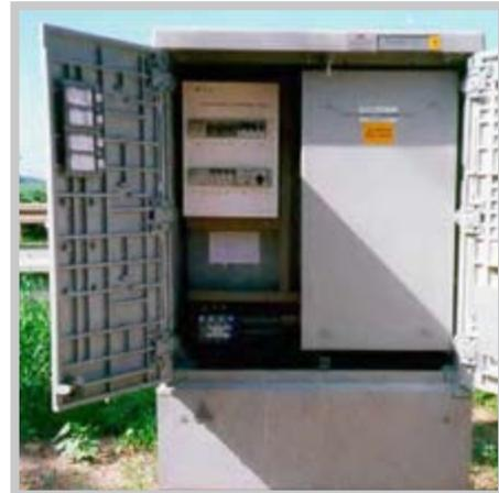
Eine zusätzliche Öffnung in der Seitenwand oben verbessert die Durchlüftung und garantiert die Einhaltung der Grenztemperaturen von  $-50^{\circ}\text{C}$  bis  $+60^{\circ}\text{C}$ , die die Trafohersteller vorgeben. Bei größeren Anlagen besteht die Möglichkeit einer Lösung mit einem Modulschrank.
