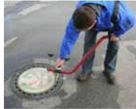
*Der Haken wird an einer Öffnung, z. B. Griffmulde oder Entlüftungsloch Schachtdeckel eingehängt.*
