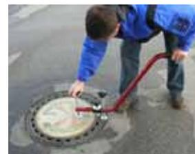
*Durch Drehen der Sterngriffe werden beide Füße fest an den Schachtdeckel gepresst.*
