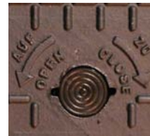
Blindverschluss - keine Verriegelung installiert -
