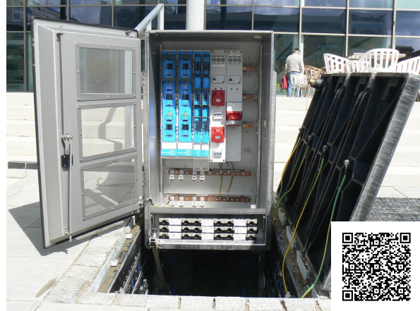
Unterflurverteiler
