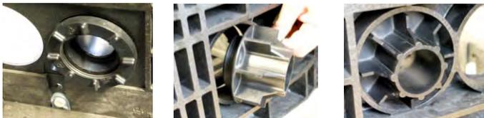
Der Rohradapter besteht aus zwei Teilen, die jeweils an der Innen- und der Außenseite der Sollbruchstelle angelegt und miteinander verschraubt werden.
