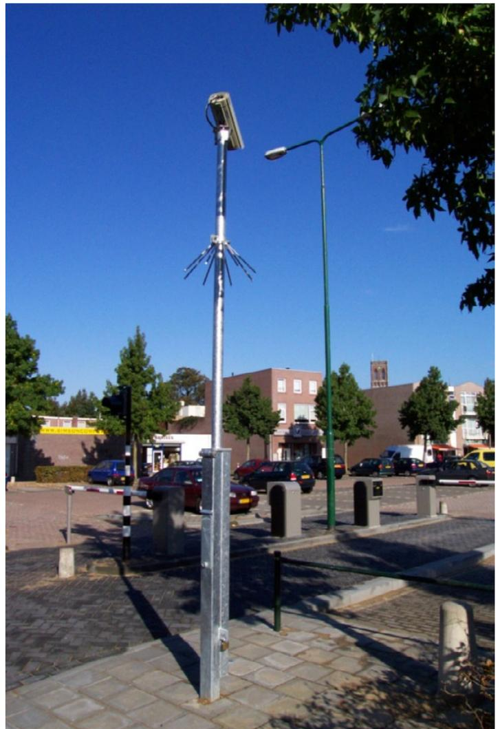
Abgesetzter Kamera-Kippmast mit Kletterschutz
